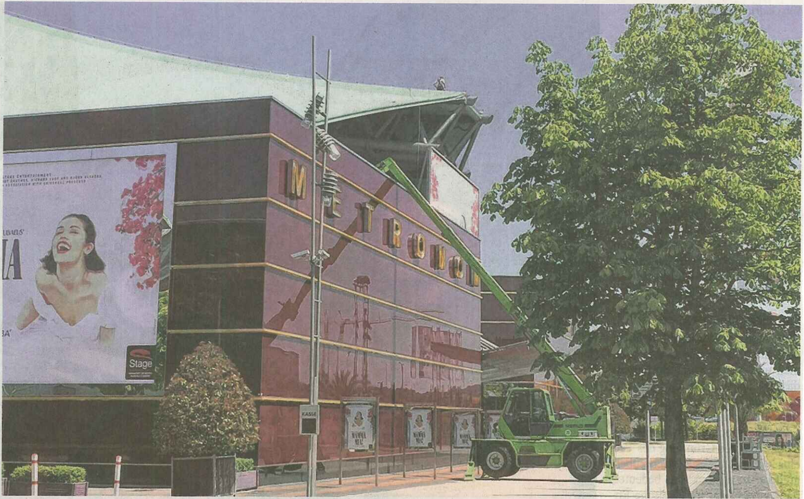
Schönheitskur für den Metronom-Drachen: Am Montag wird zur Seite der Osterfelder Straße die erste Verkleidung der neuen Dachfolie befestigt. FOTOS: STAGE ENTERTAINMENT
