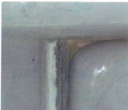
Bild 3: Obere linke Ecke des linken Membrankissens. Die zwischen Kissen und Prüfstand vorhandene Öffnung wurde vor der Messung mit Terostat abgedichtet (siehe Bild 1).
