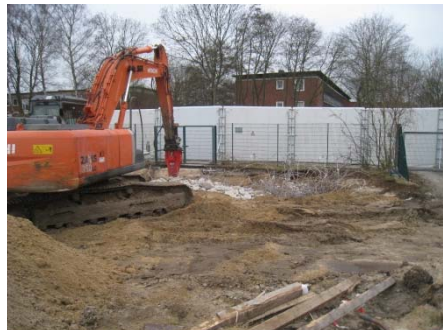
Abriss Beton Fundamente Umspannwerk Hamburg
