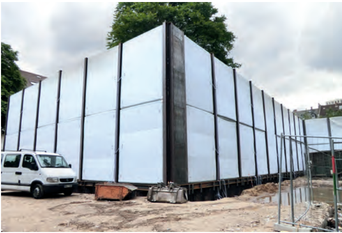
Abb. 1 und 2: Mobile Lärmschutzwände CENO-WALL (Fotos: CENO Membrane Technology)
