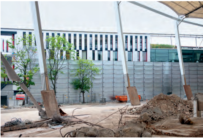
Abb. 3: Temporäre Schallschutzwände (Foto: Layher)
