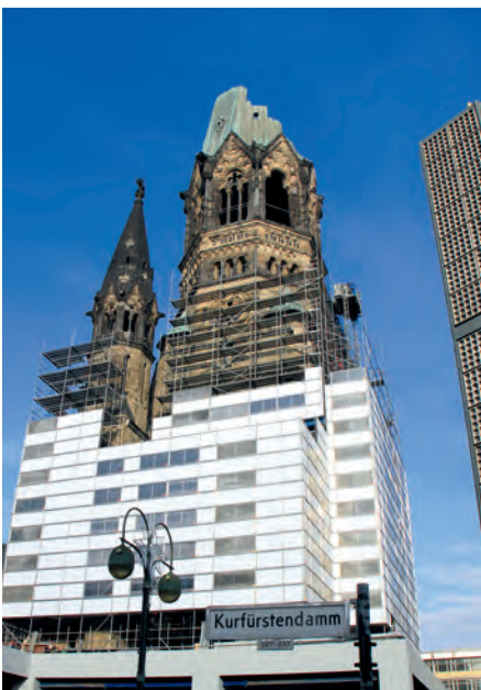
Abb. 5: Das Protect System an der Berliner Gedächtniskirche (Foto: Layher)
