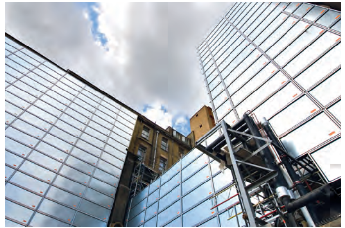
Abb. 4: Einsatz des Protect Systems an einem Krankenhaus (Foto: Layher)
